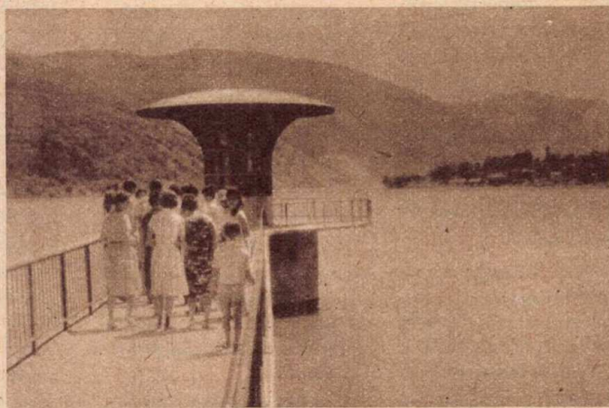
Paneserevó, vízkivételi berendezés
